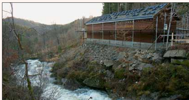
Vannglassdosereren som er under bygging i Lygna. Foto: Edgar Vegge.
